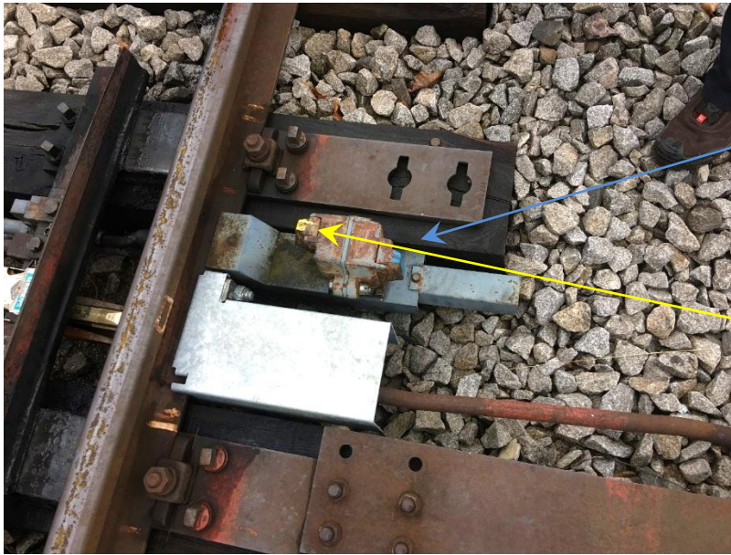
Bild 7; Verschluss an der Weiche 1
